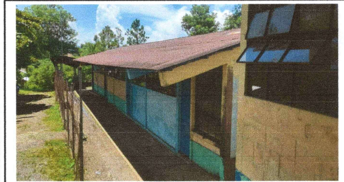
Foto1: mantenimiento a estructura de techo.
