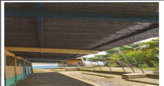
Foto 4: Mantenimiento a estructura de techo
